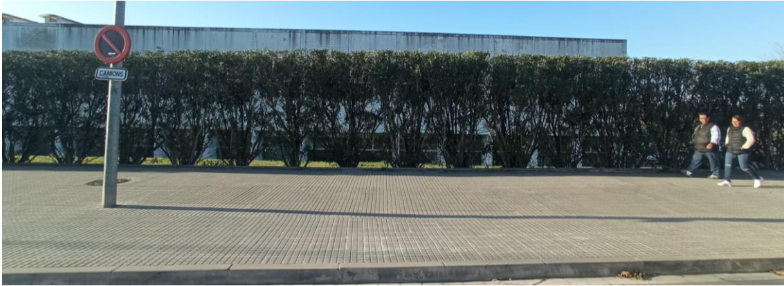
Vorera a millorar - Carrer de Vallseca
