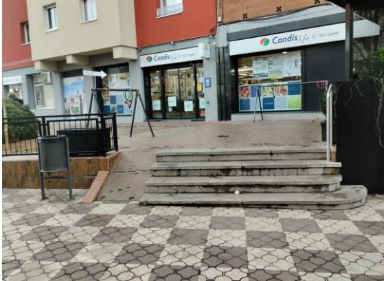
Escales i rampes a enderrocar
