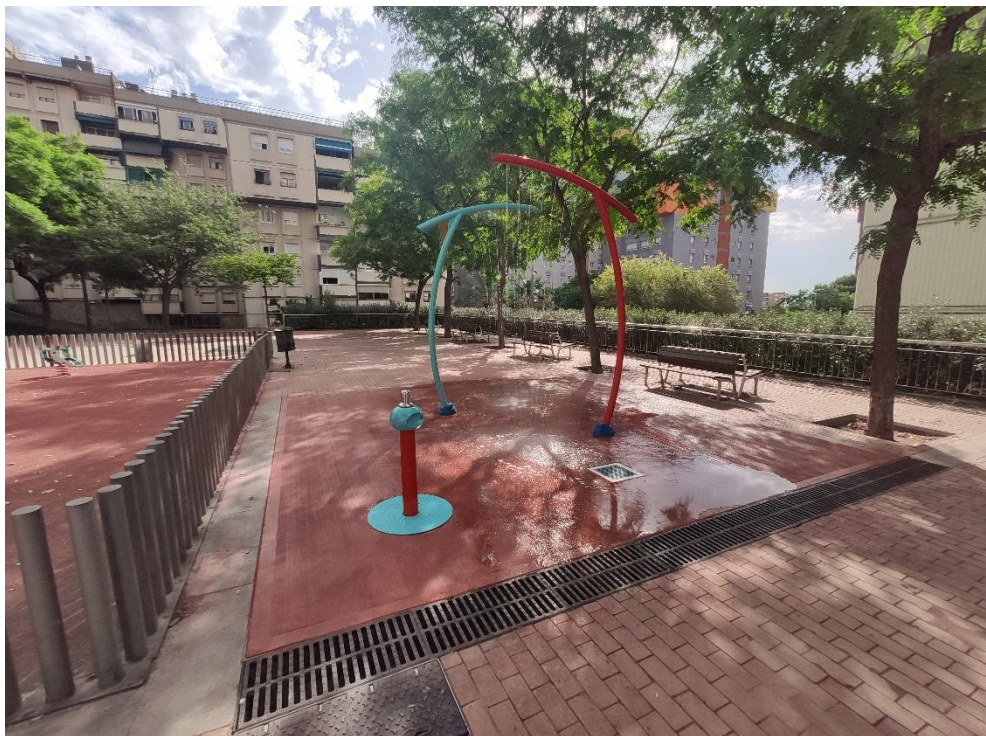
Font ornamental splash pad sense recirculació
