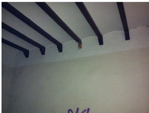
Fig. 42 – Forjat de revoltons sobre bigues (planta baixa, menjador).
