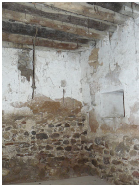
Fig 4a. Sòcol de palet de riu lligat amb morter sobre el qual s'aixeca la tàpia (cós transversal o celler)
