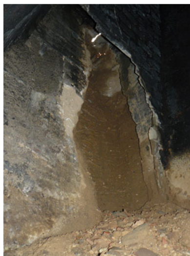
Fig. 15 – Esvoranc obert per filtració d'aigua a la paret de la cuina
