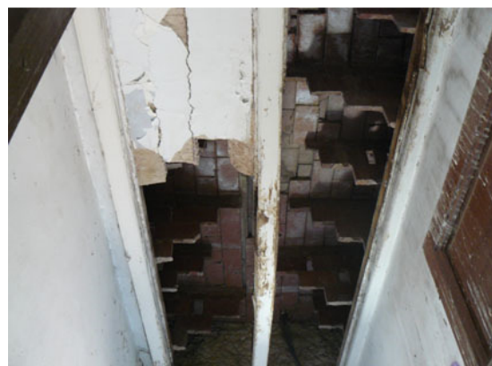
Fig. 43 – Terrat a la catalana a) terrat a l'exterior b) espai del sostremort que forma part del terrat a la catalana
