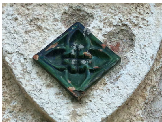
Fig. 44 – Rajola verda que constitueix la base ornamental de les obertures de la façana
