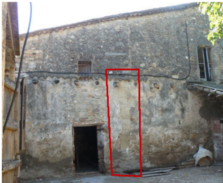
Fig. 4b – Cantonera nord-est de la masia original, a la façana posterior.
