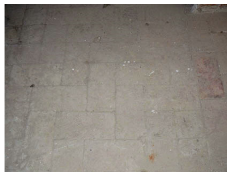
Fig. 28 – Detall del paviment de rajol ordinari a la mescla
