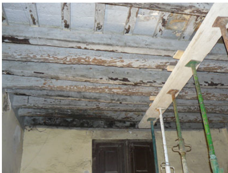
Fig. 6 – Embigat amb bigues de fusta, llates i solera de rajol quadrangular (cuina)
