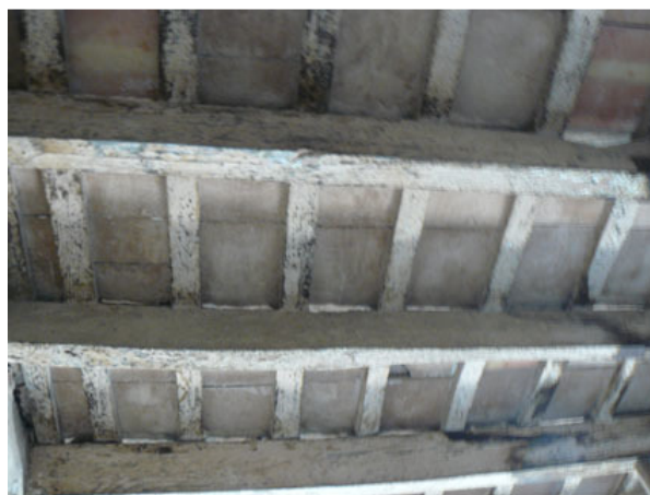
Fig. 26 – Forjat sobre la sala.
