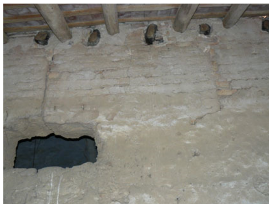
Fig. 5b – Detall d'una tapiera i les filades de rajols al parament exterior de la masia (cós annex, P1), ara dins el conjunt arran la construcció de l'annex est.
