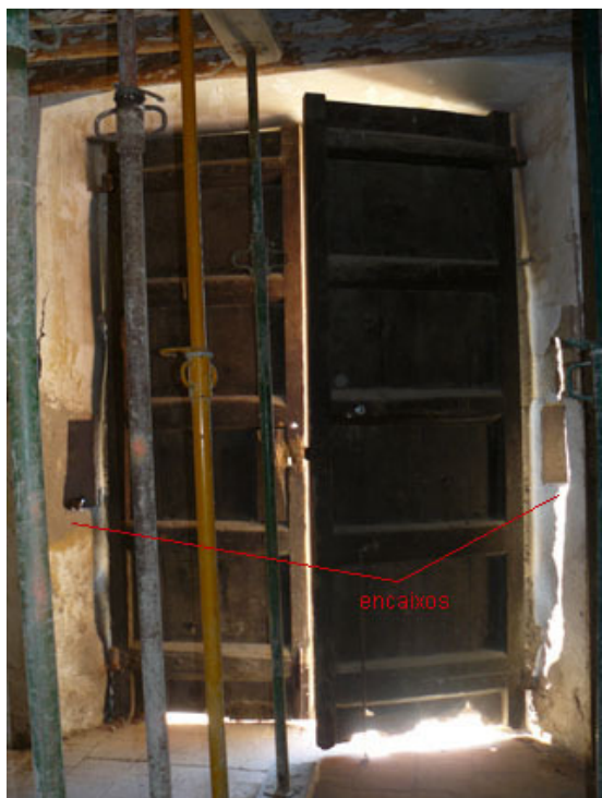
Fig 11 – Portal d'accés al vestíbul, i encaixos per a la barra de seguretat. Fig. 12 – Rebost sota la volta de l'escala.
