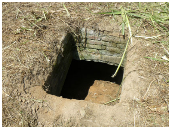
Fig. 36 – Dipòsit al subsòl al peu de la façana est: a) sistema de conducció des de la coberta b) arqueta c) accés al dipòsit d) interior
