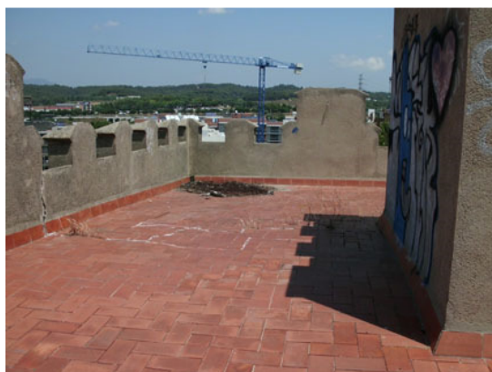
Fig. 43 – Terrat a la catalana a) terrat a l'exterior b) espai del sostremort que forma part del terrat a la catalana
