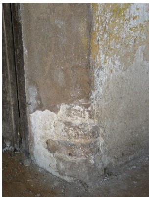
Fig. 20 – Porta del vestíbul a la cuina, amb detall dels maons escantonats
